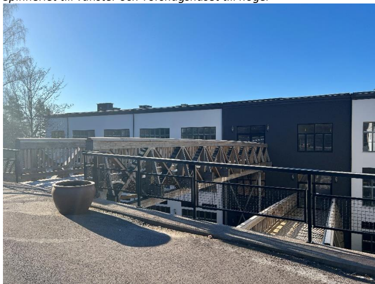
Gångbro (tål biltrafik) med huvudentré till byggnaden
