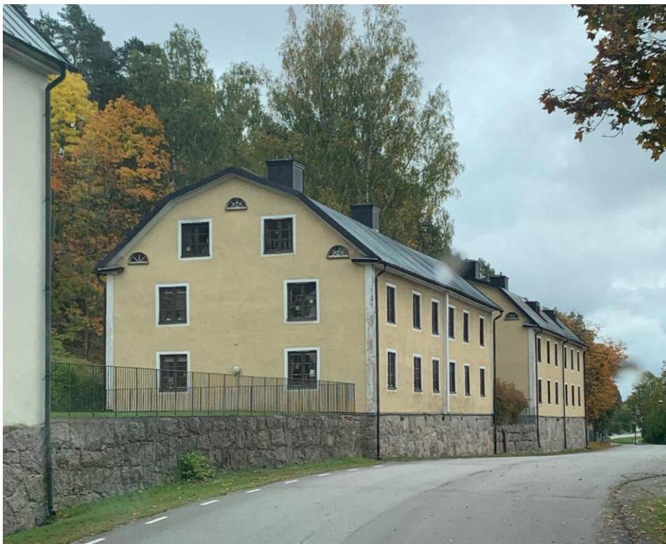
Figur 24. Bilden ovan visar en av arbetarbostäderna. Bilden nedan är tagen från Katrineholmsvägen och visar arbetarbostäderna och den höga grunden. Foto: Fanny Germer, 2022-09-14.
