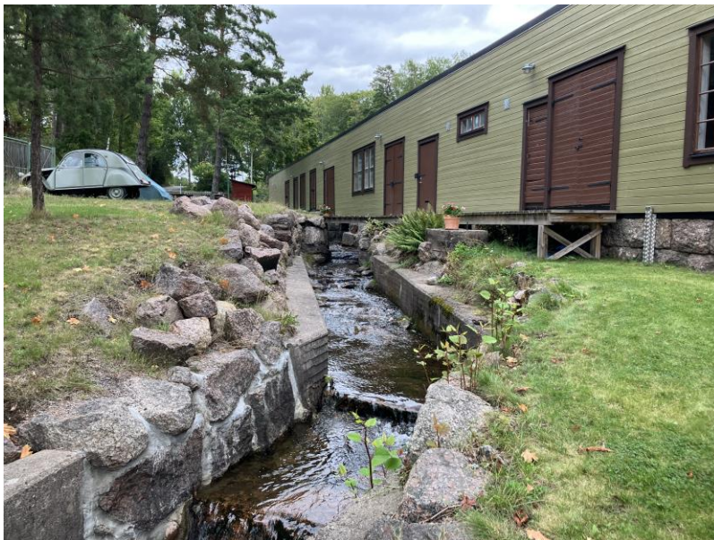
Figur 28. Bilden visar en av ekonomibyggnaderna som finns inom planområdet samt del av kanalen som rinner genom området. Foto: Fanny Germer, 2022-09-14.
